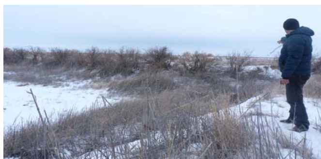
Рисунок 1 – Действующий Бугут №1, гребень земляной плотины.
